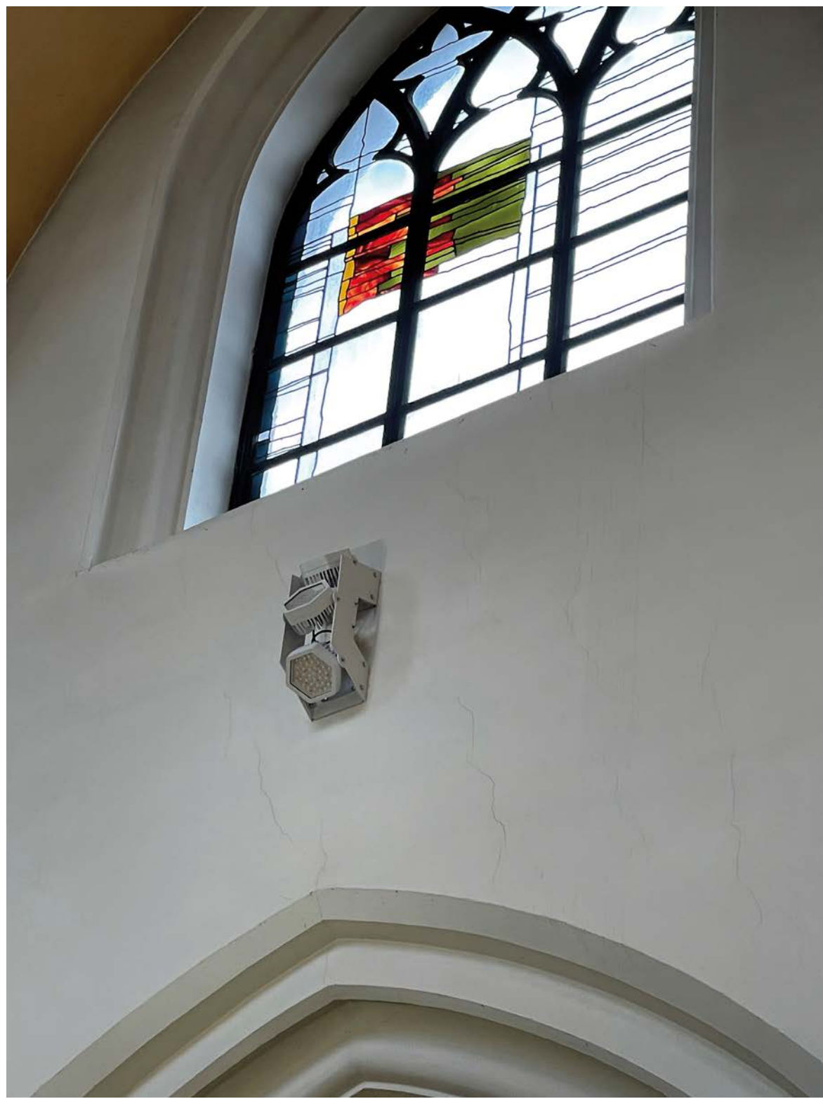
Detail, armatuur voor drie lichtbronnen
