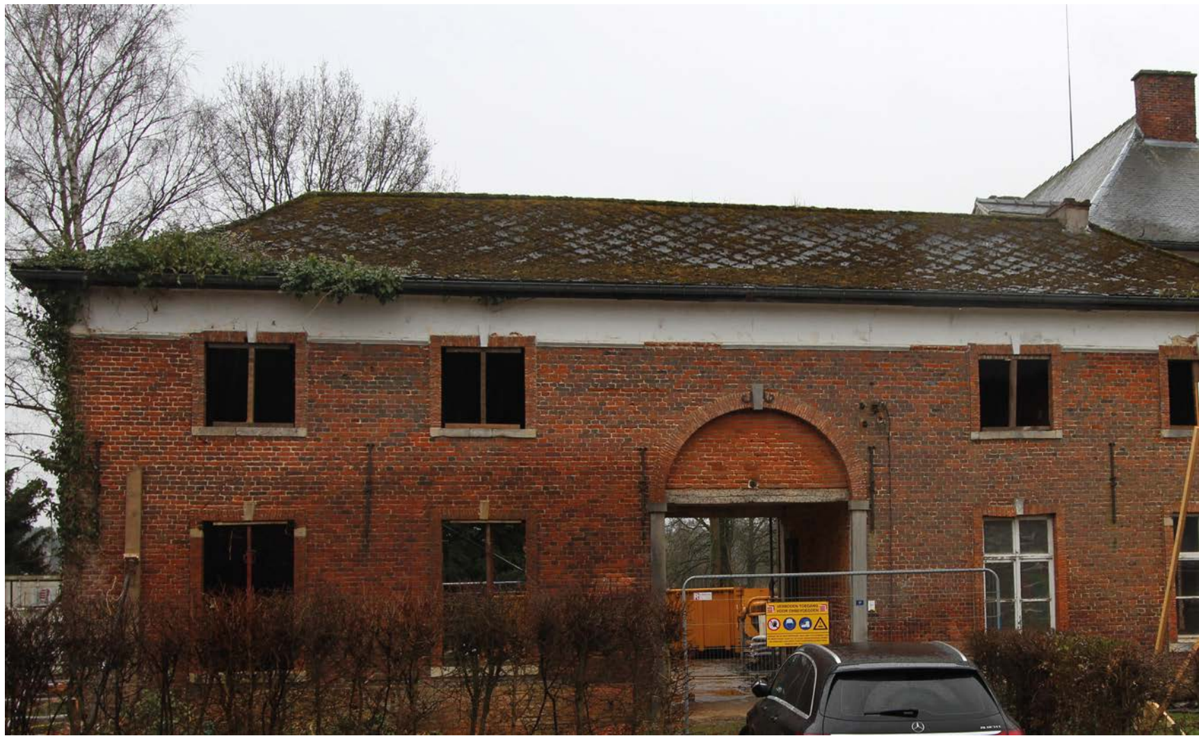
Afbraak buitenschrijnwerkerij noordzijde poortgebouw
