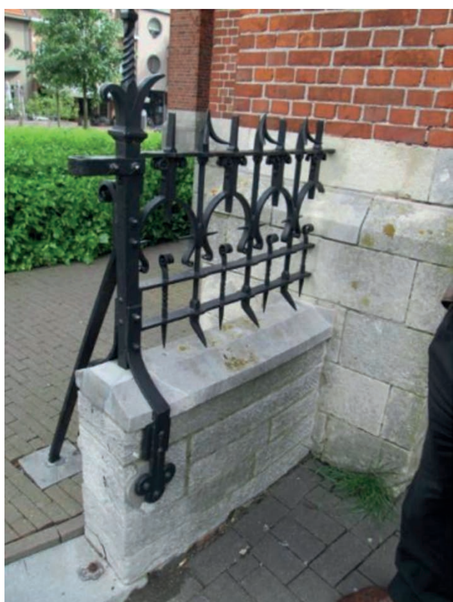
Voormalige proefrestauratie: plan heropbouw basementen met daarop alle hekwerken.
