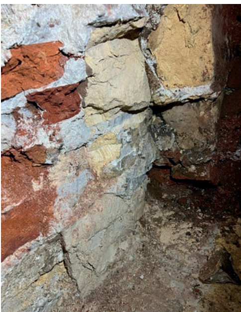
Verschillende materialen als funderings metselwerk.
