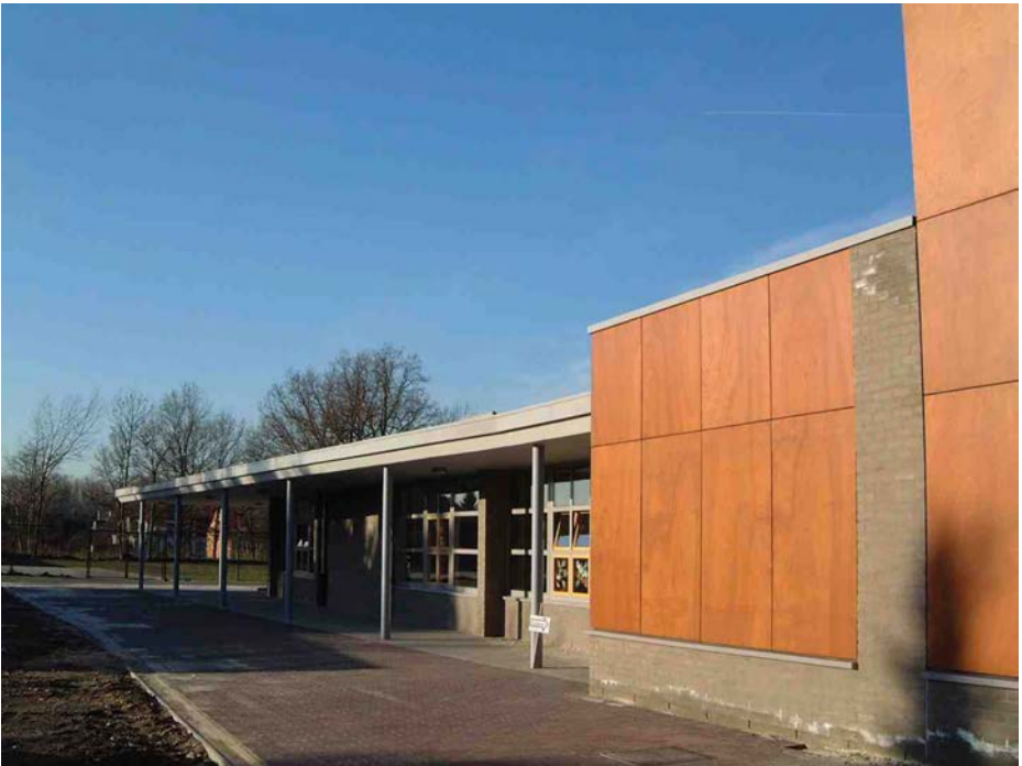
Voorgevel (gebouw A en aanzet B)
