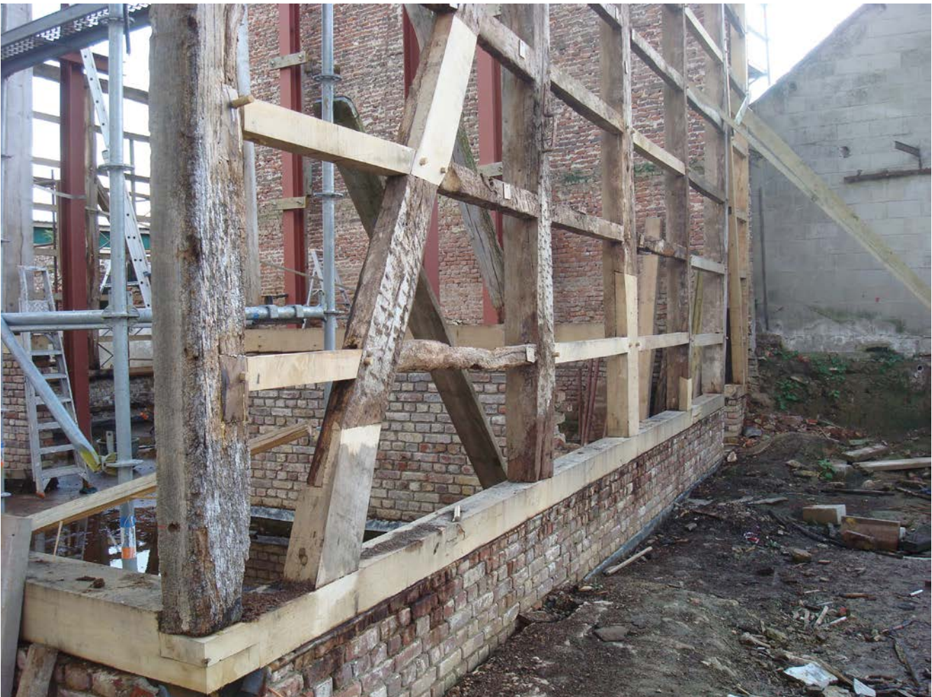
Fragmentarische vervanging vakwerk
