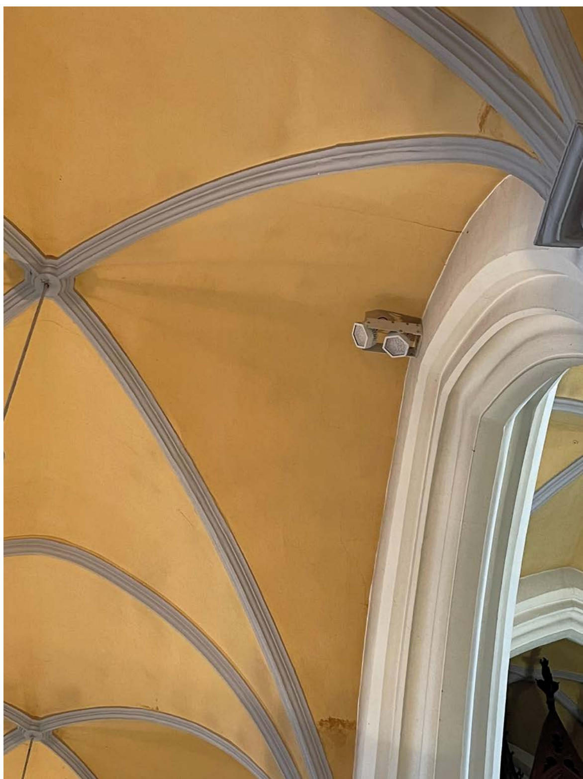
Armatuur met twee lichtbronnen (zijbeuk zuid)
