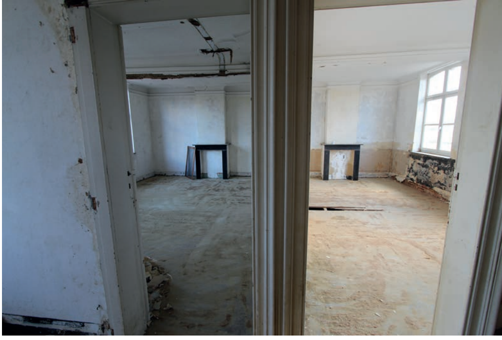
Verwijderde linovloeren op bestaande planken
