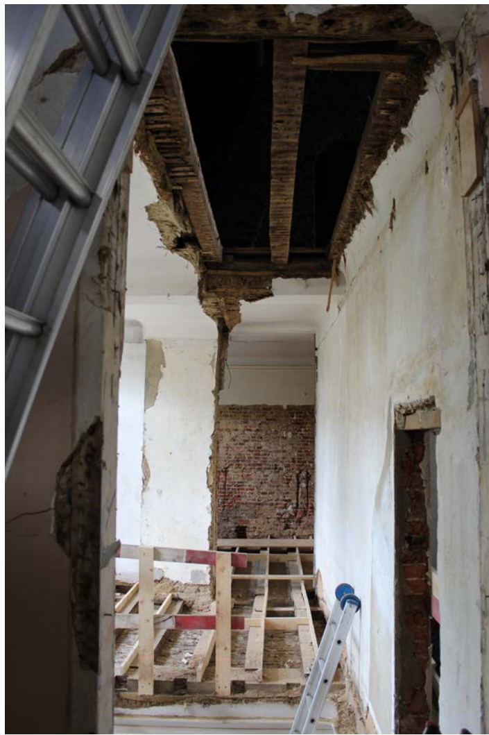
Doorbrekingen voor deuren en trap
