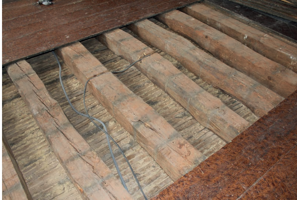
Draagbalken en vrijkomend vitselwerk
