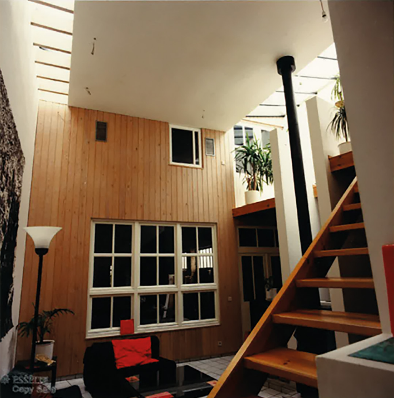
De houten wand waarachter de originele schrijnwerkerij is een reminiscentie van de originele beplankte binnengevel. In eerste instantie was dit ook het atelier van Fred. Rechts boven is de verbinding van de verdieping: van slaapkamers naar de uitbreiding atelier. Links en rechts van dubbelhoge plafond is een lichtstraat voorzien over de ganse diepte van de zitruimte.
