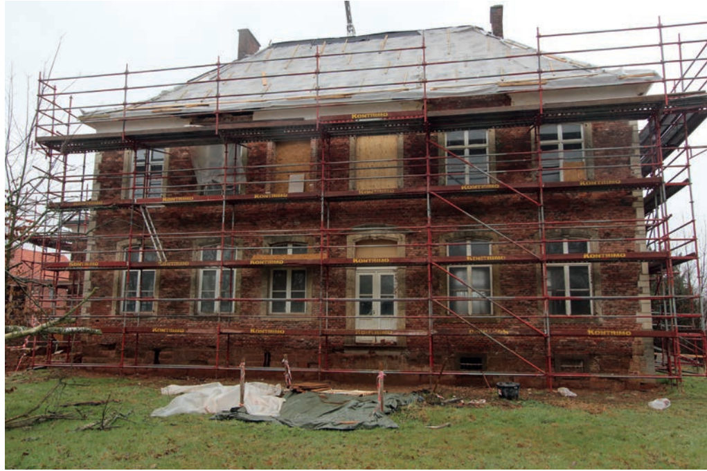
Afbraak buitenschrijnwerkerij noordzijde poortgebouw
