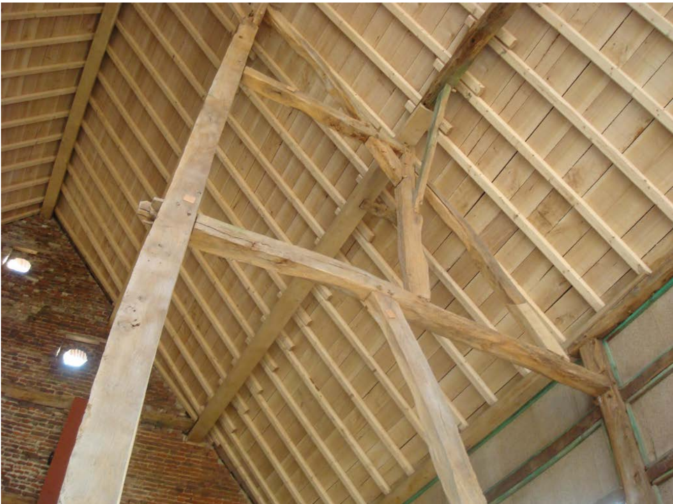
Afwerking dak binnenzijde schuur
