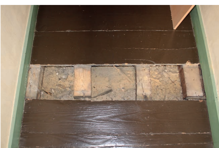
Onderzoek op de balklagen op verschillende niveau's
