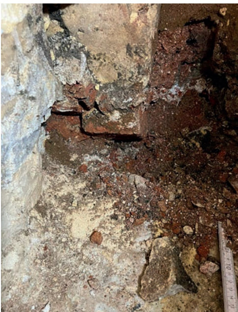
Uitgraving hoger gelegen fundering van de binnenmuur
