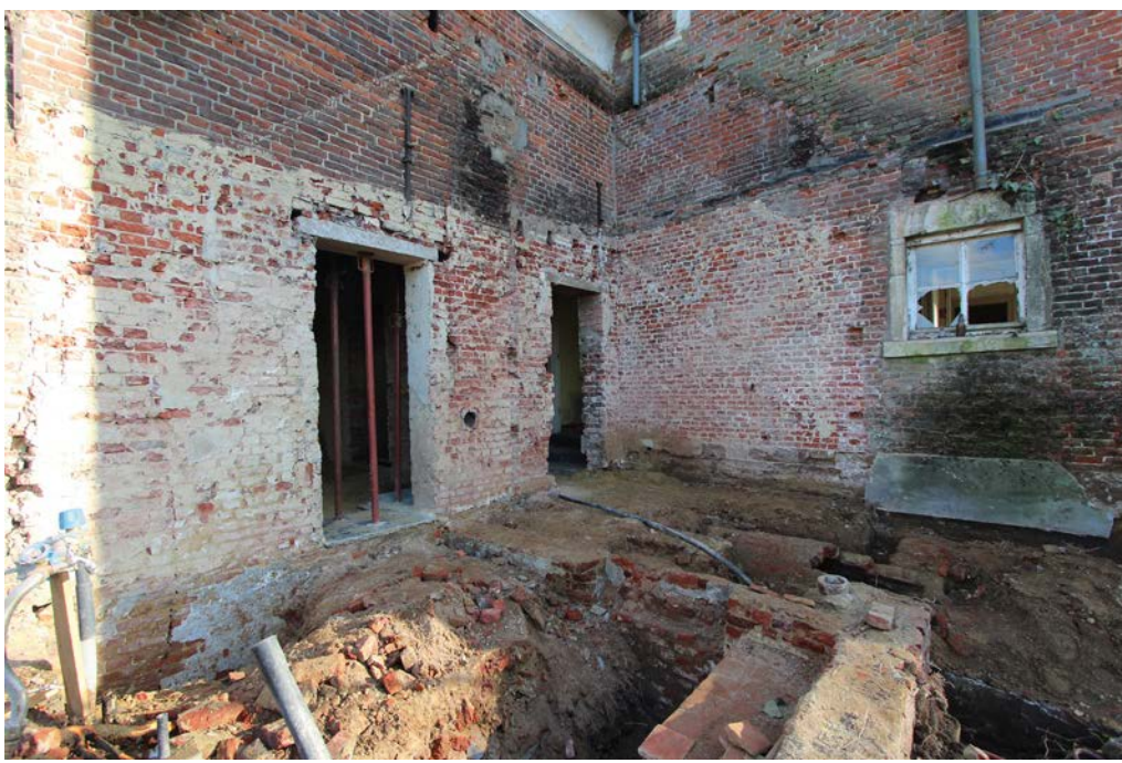
Afbraak gebouw van 1965
