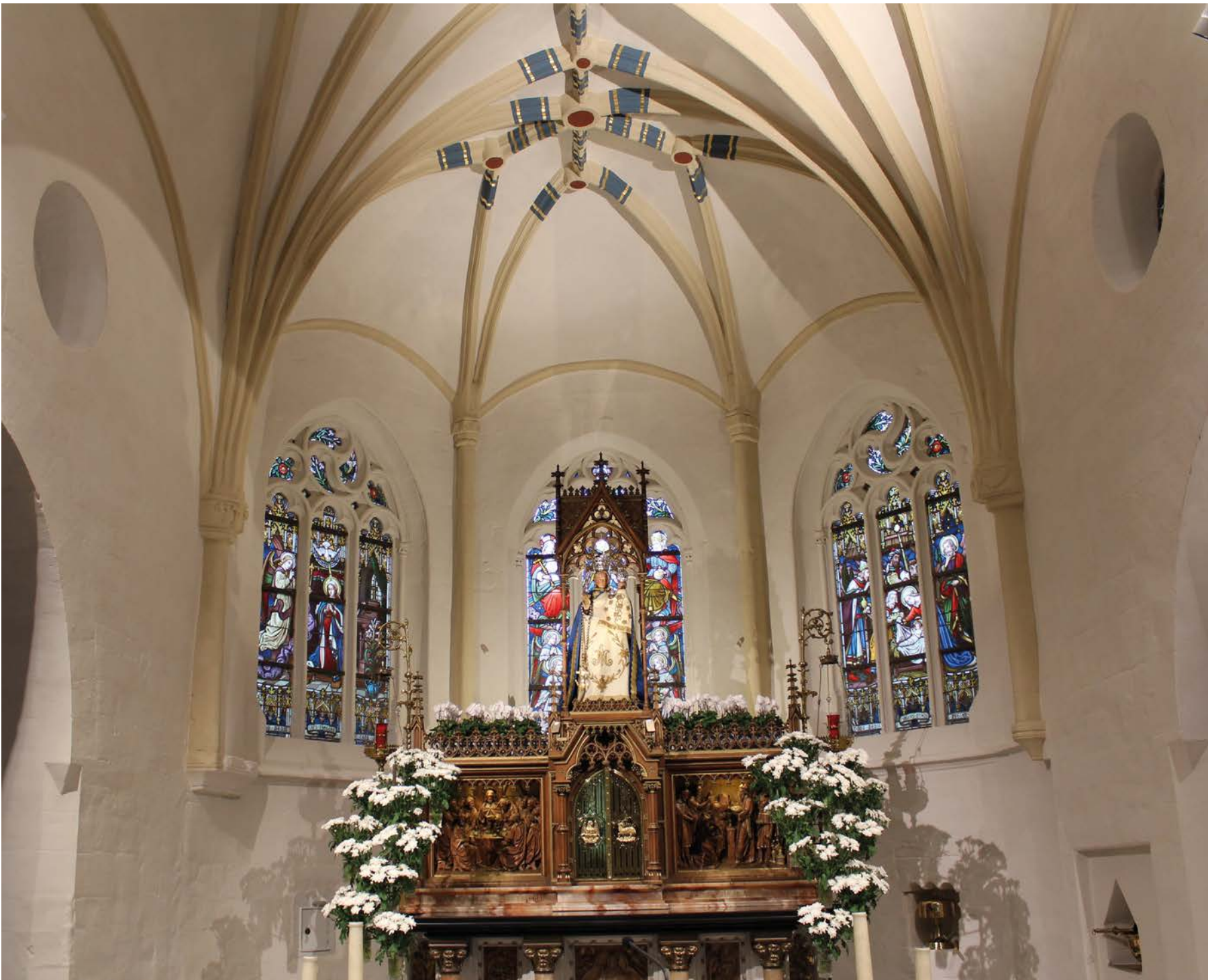
Nieuwe kaleitoepassing op muren en gewelven. Neogotisch altaar in een gotisch koor en absis.
