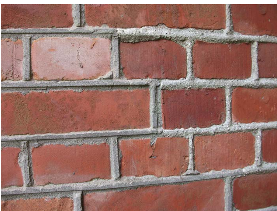
Voorbeeld van knipvoeg/ voormalige proefherstelling
